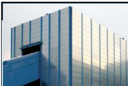
Photos d'écrans insonorisant ILG ceinturant une installation de broyage
