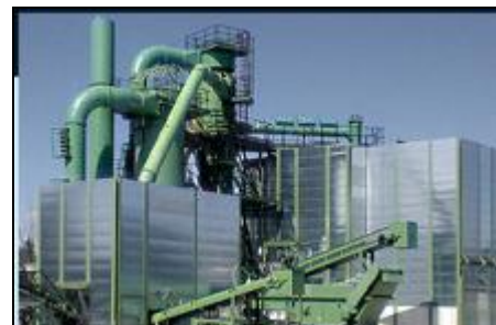
Photos d'écrans insonorisant ILG ceinturant une installation de broyage
